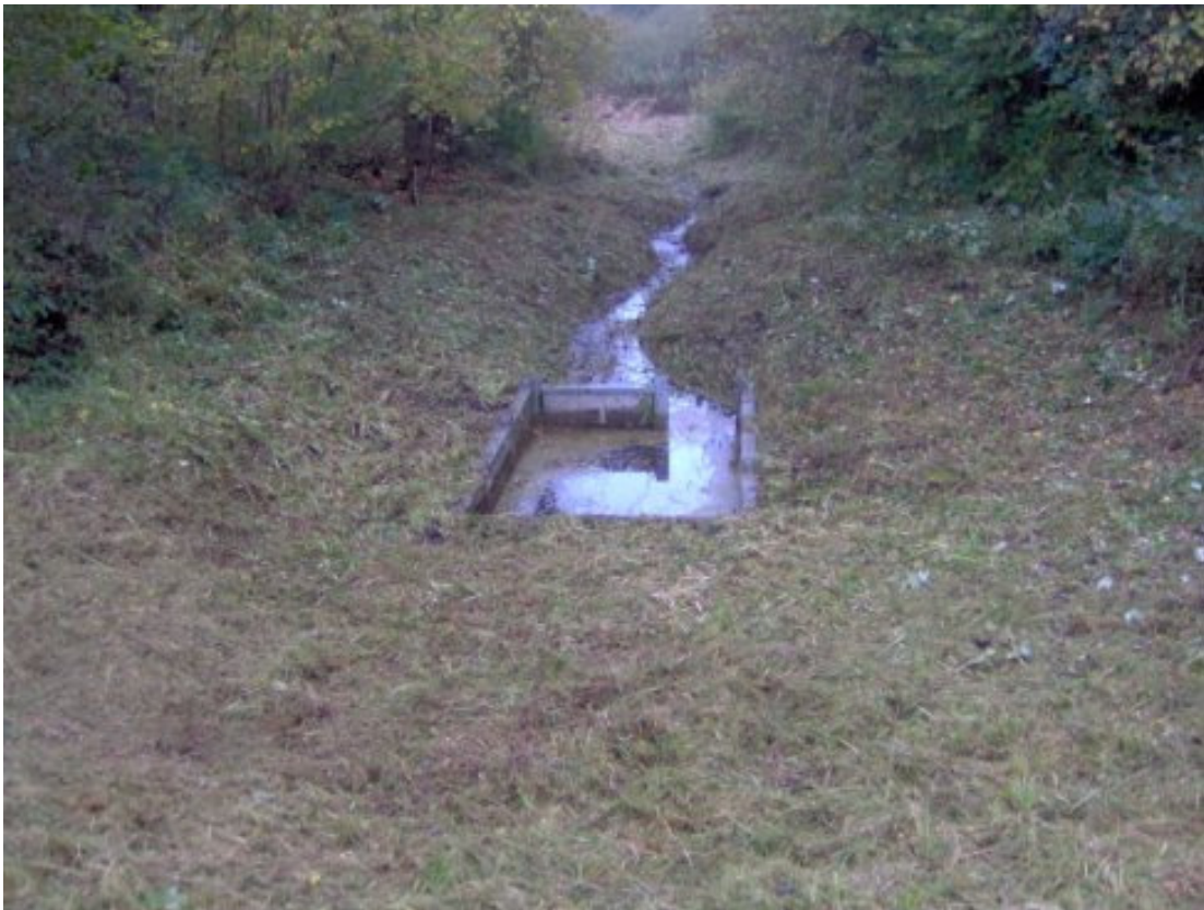
Das Abfischbecken mit dem Bach zum Schlammbecken.
